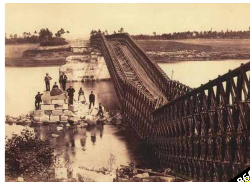
Zničený železniční most přes Labe u Neratovic
