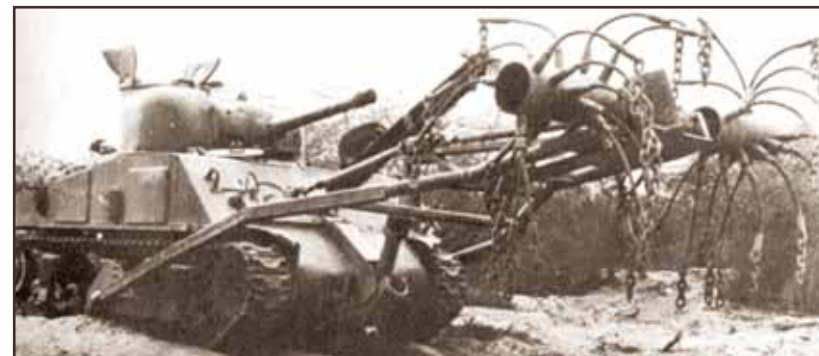
Střední tank Sherman opatřený odminovacím zařízením bichho typu
