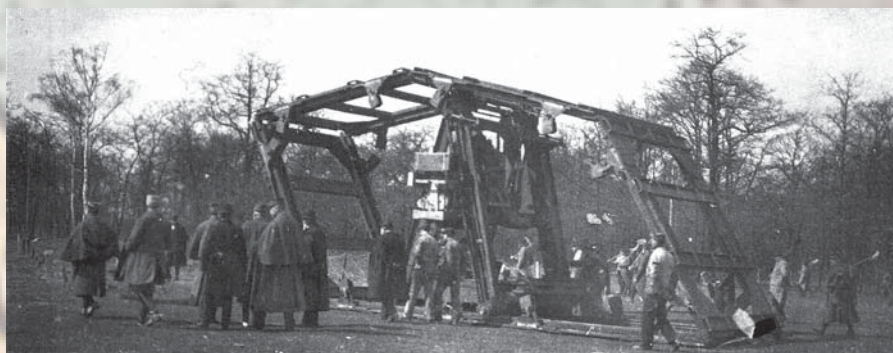
Francouzský prototyp Boirault měl ještě místo pásů posuvné rámy
