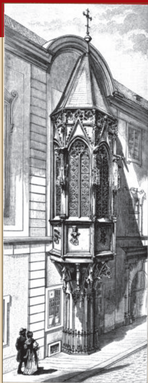
Arkýř vystupující do ulice z historické budovy Karolina
