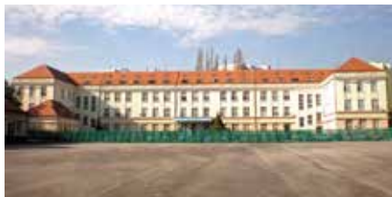
Objekt dislokace hydrometeorologických odborů úřadu v Praze-Ruzyni
