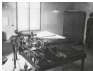
První letoun vybavený pro letecké snímkování – jednomotorový dvojplášník Aero A-38-1, lidově zvaný Baba (vlevo); první vyhodnocovací přístroj pro pozemní fotogrammetrii (vpravo)
