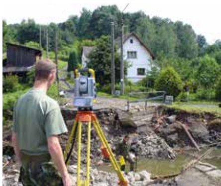
Měřické práce při výstavbě mostních provizorií v období odstraňování následků ničivých povodní
