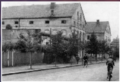
Objekty bývalé textilní továrny firmy Czajaneck v Místku, kde se vojáci III. praporu pěšího pluku 8 „Slezského“ postavili na odpor německým okupantům, již neexistují...
