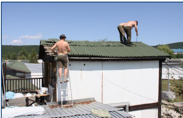
Vojenská kaple, začátek demontáže
