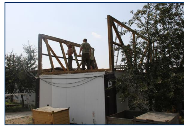
Střecha kaple po demontáži vrchní části
