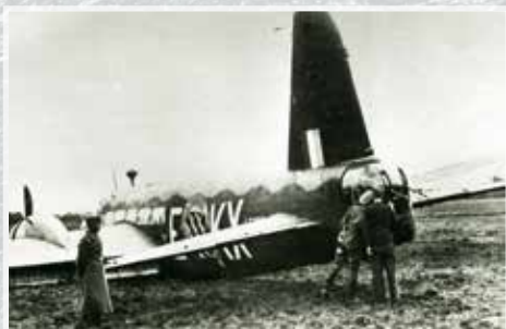
Prvními čs. letci, kteří okusili strasti německého zajetí, byla osádka npor. Karla Trojáčka. V noci z 23. na 24. září 1940 při návratu z nočního bombardování Berlína musela pro poškození nouzově přistát poblíž Leidschendanu v okupovaném Nizozemsku. Jeden letec se při zatýkání zastřelil, zbylých pět bylo zajato. Přestože německá justice s nimi chtěla naložit jako s „velezrádci“, britská uniforma je nakonec chránila velmi účinně.
