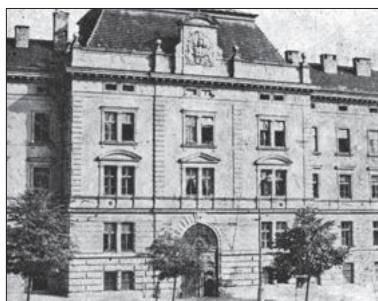
Budova v Praze na Pohořelci, sídlo tělovýchovného oddělení ÚDA
