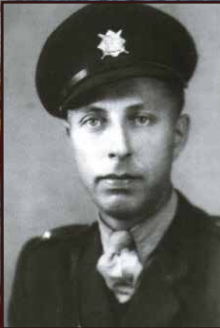
Třetím k smrti odsouzeným a popraveným v tomto vykonstruovaném procesu byl vězeňský dozorce, strážmistr Čeněk Petelík.
