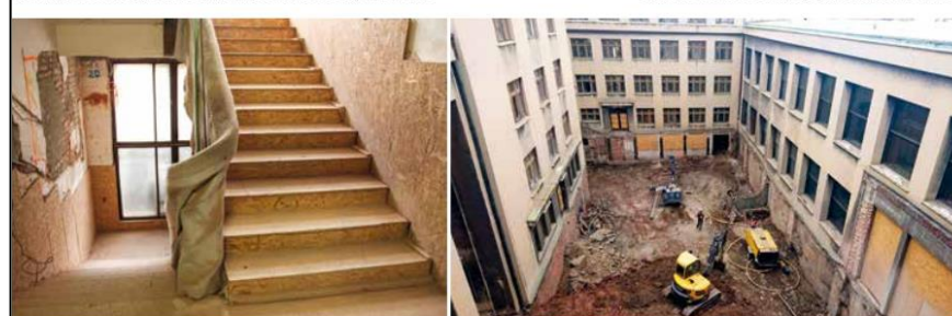
Práce ve vnitřních částech muzea, schodiště správní budovy
