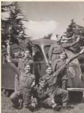
Vojáci čs. jednotek ve Spojeném království s novým sanitním vozem, který doputoval z USA.
