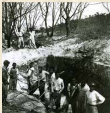
Rákosové domky a zemljanky neposkytovaly žádnou ochranu před bombardováním a ostřelováním z kulometů. Nemocnice totiž nebyla vyslána pod hlavičkou Čs. červeného kříže. Podle ženevských úmluv by musel být o jejím zasazení předem informován nepřítel, což čs. i severokorejská strana odmítly.
